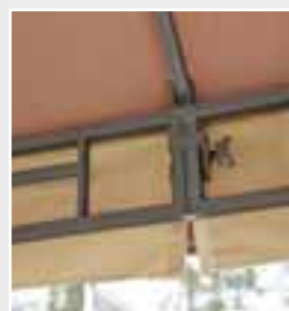
Schnellverschluss mit Schraubklemmen
