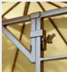
Schnellverschluss mit Schraubklemmen
